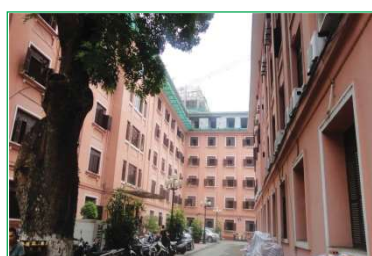
Gạch nhẹ SCL-BLOCK xây nâng tầng Trụ sở Bộ Kế hoạch và Đầu Tư
