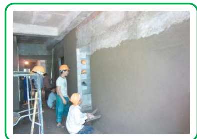
Trát tường bằng vữa trát SCL-MORTAR
