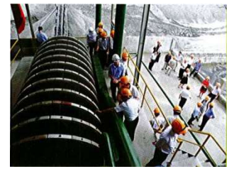
Hệ thống vắt lọc tro bay
