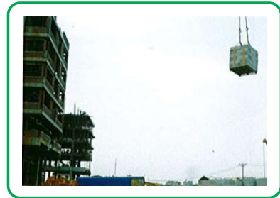
Chuyển gạch lên tầng xây bằng cầu tháp
