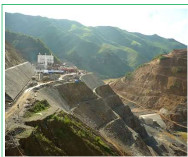
Tro bay sử dụng trong bê tông tại công trình thủy điện Bản Chát, 2010
