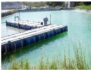
Bể chứa tro xỉ
