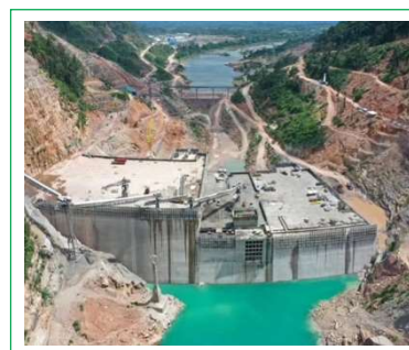
Tro bay đang sử dụng tại công trình Nam Theun 1, Lào, 2020
