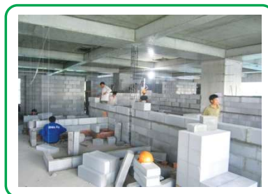
Xây hoàn thiện tường gạch
