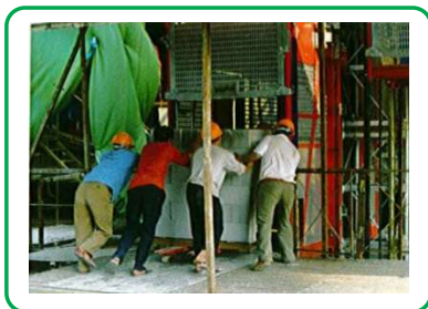
Chuyển gạch lên tầng xây bằng vận thẳng
