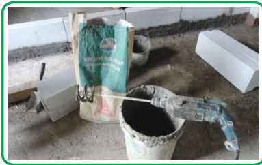
Dùng cánh khuấy lắp vào máy khoan cầm tay để trộn vữa
