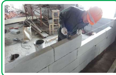
Căn chỉnh gạch bằng búa cao su
