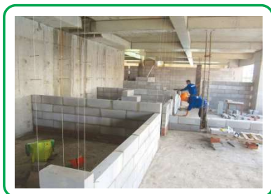
Xây thân tường bằng vữa xây SCL-MORTAR
