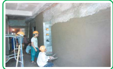
Trát tường hoàn thiện
