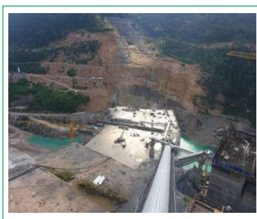
Thi công đập tại Lào
