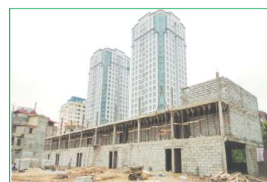
Gạch nhẹ SCL-BLOCK được sử dụng xây trường Đại học Nguyễn Trãi
