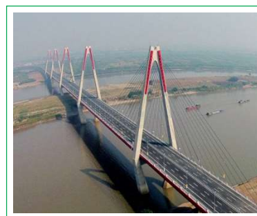
Tro bay sử dụng trong bê tông tại công trình cầu Nhật Tân
